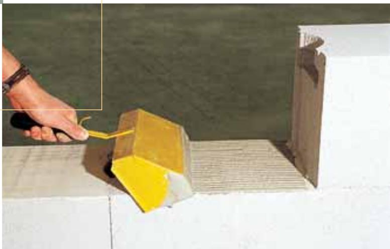
El mortero-cola PREOCOL+ está destinado a la aplicación en junta fina de 1,5 a 2 mm, incorpora retenedores de agua y está diseñado para ser usado con los bloques o tabiques YTONG, de acuerdo al DAU 03/12. Está amasado con un 30% de agua aproximadamente, mediante un batidor de velocidad media.
