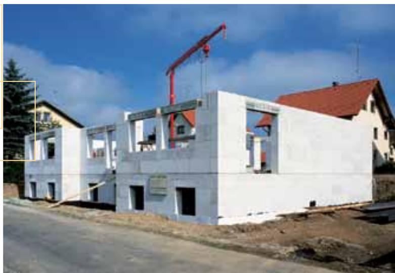
Hay que destacar que los muros de carga asumen también el papel de muro de cortante, por lo que deberán absorber tanto el esfuerzo vertical como el esfuerzo cortante.
