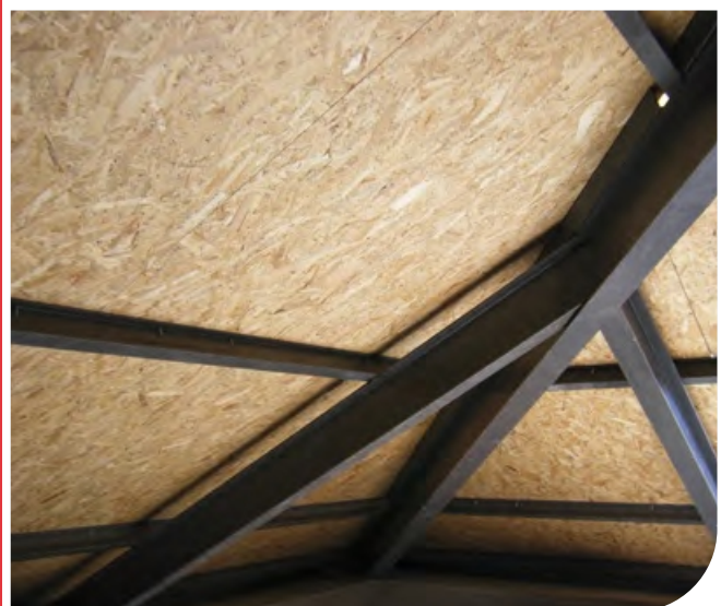
Aplicación sobre estructura metálica
