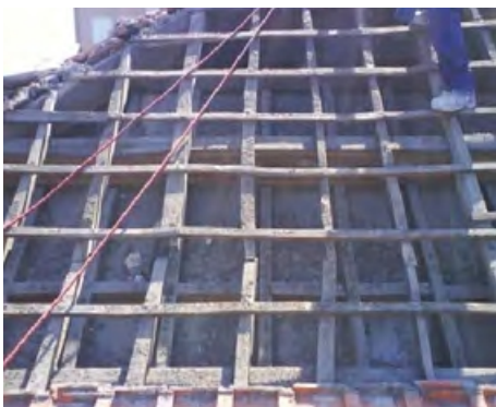
1º Retirar teja y revisar estructura
