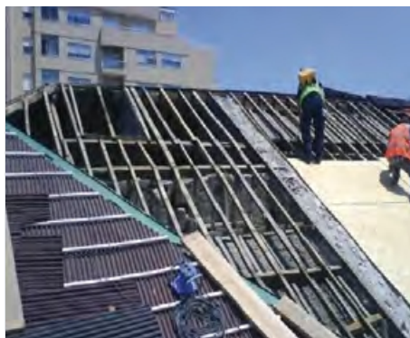
2º Instalar tableros OSB Onduline®
