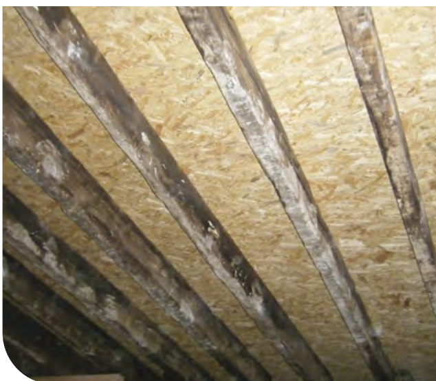
Aplicación sobre entramado antiguo de madera
