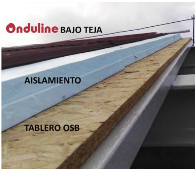
Sistema OSB + Onduline® Bajo Teja (con aislamiento)
