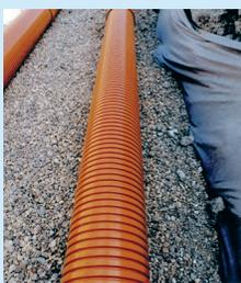
Doble pared (interior lisa, exterior corrugada) soldada por termofusión durante el proceso de fabricación de extrusión en continuo. El equipo ranurador, sincronizado con el de corrugación, realiza las ranuras para el drenaje en los valles de la tubería, que son las zonas de menor espesor, por lo que se minimiza la retención al paso del agua.
